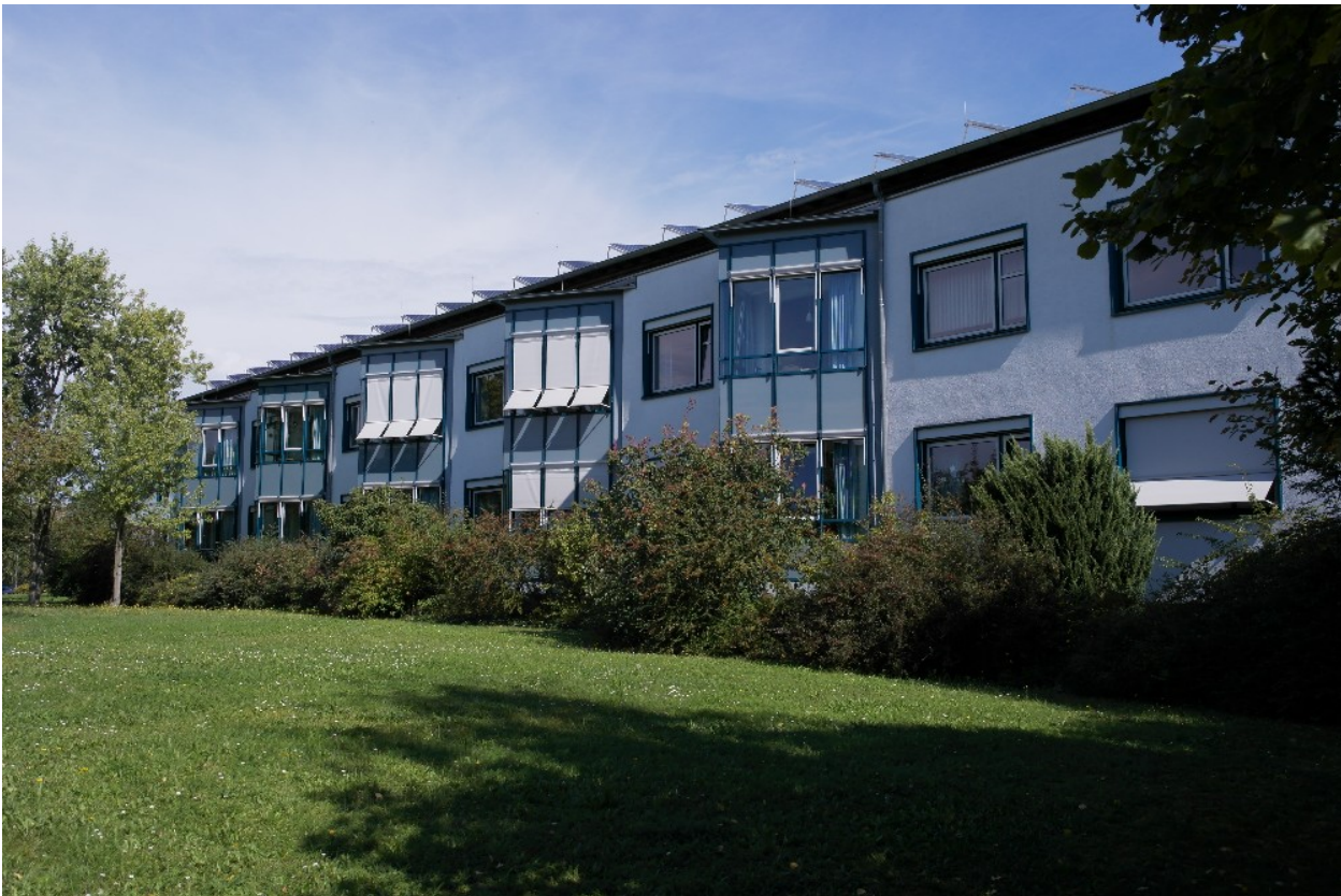
Außenansicht der Klinik mit Blick auf die Patientenzimmer.
